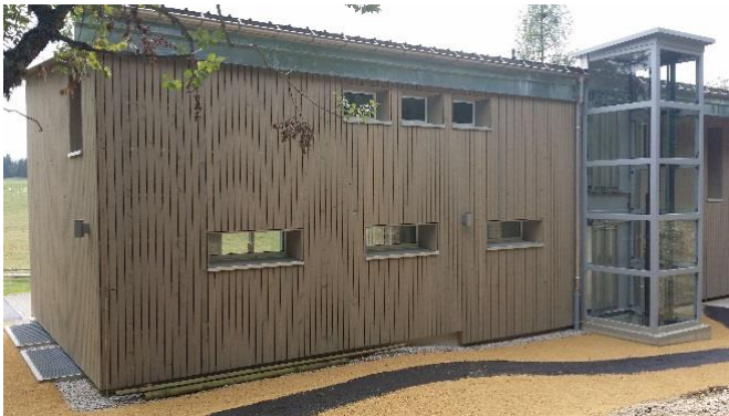
La façade isolée, le bardage en bois et le monte-personne à l'arrière du bâtiment
